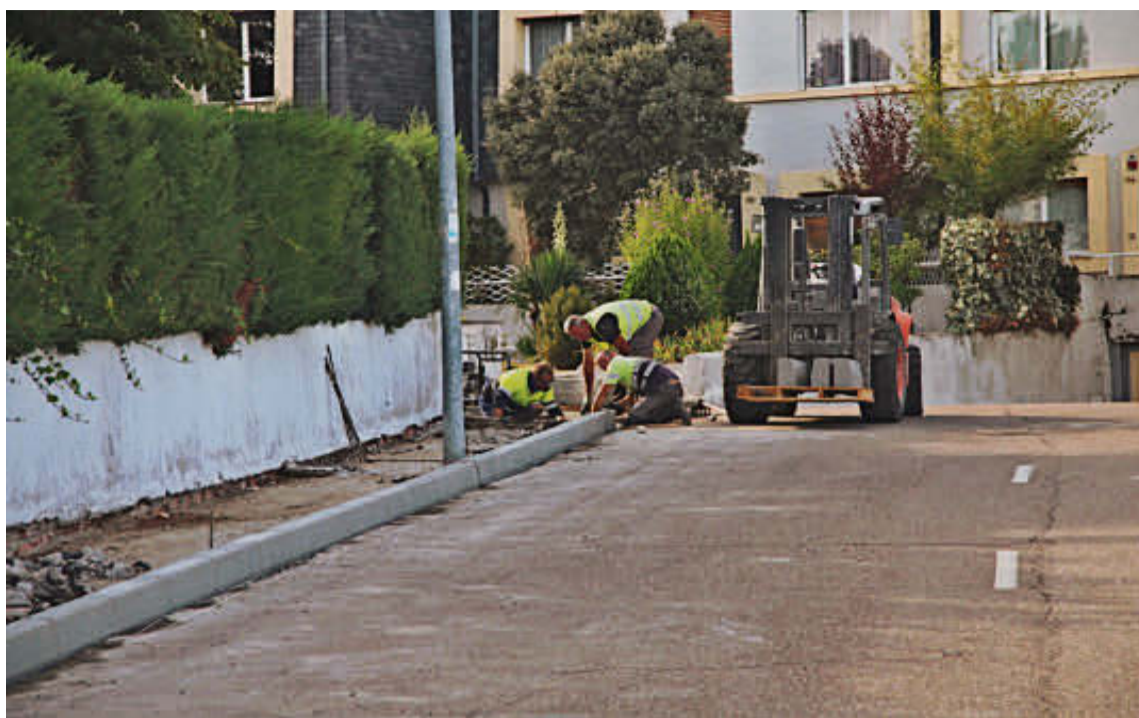
Los obreros ejecutando los Acerados de la avenida de El Viso en la urbanización homónima. | EÑE
