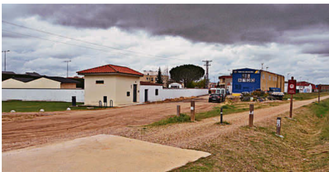
Zona donde se ejecutarán las obras de urbanización de la calle Salamanca y la zona peatonal junto a la Vía Verde. | EÑE
