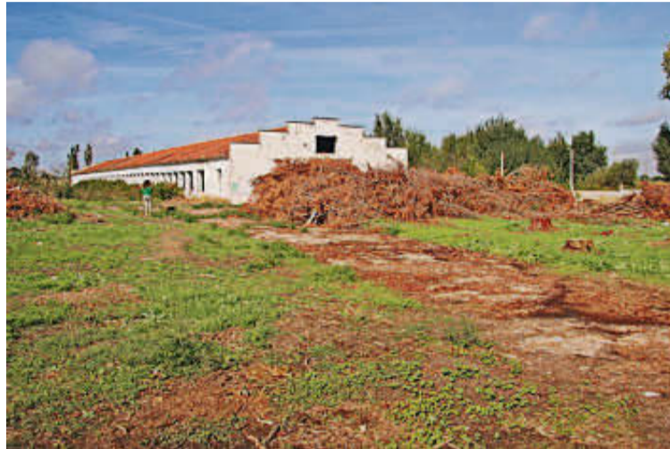
Una de las construcciones de la antigua granja de gallinas en Villamayor. | EÑE
