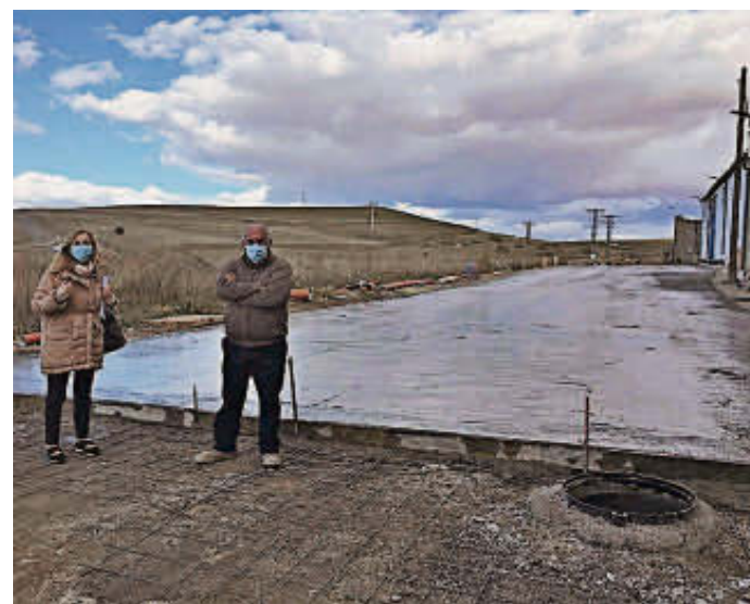
El camino de Los Coladeros durante la pavimentación. | EÑE
