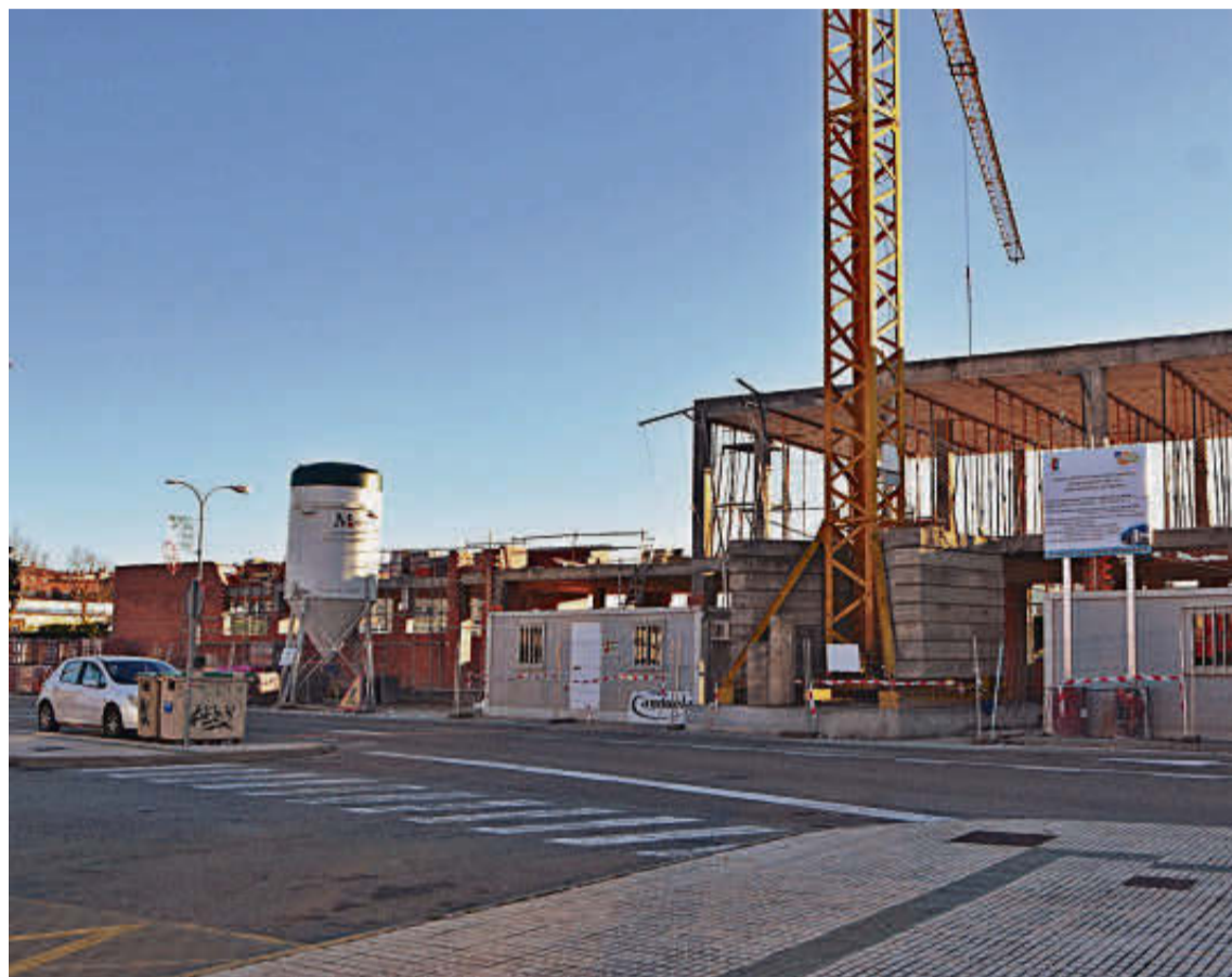
Imagen de la obra de los nuevos vestuarios de la piscina de verano, con las paredes ya levantadas. | EÑE
