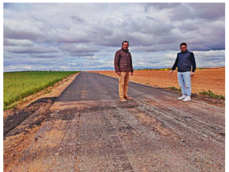
Antonio Luis Rodríguez y Guillermo Rivas en las obras de pavimentación. | EÑE
