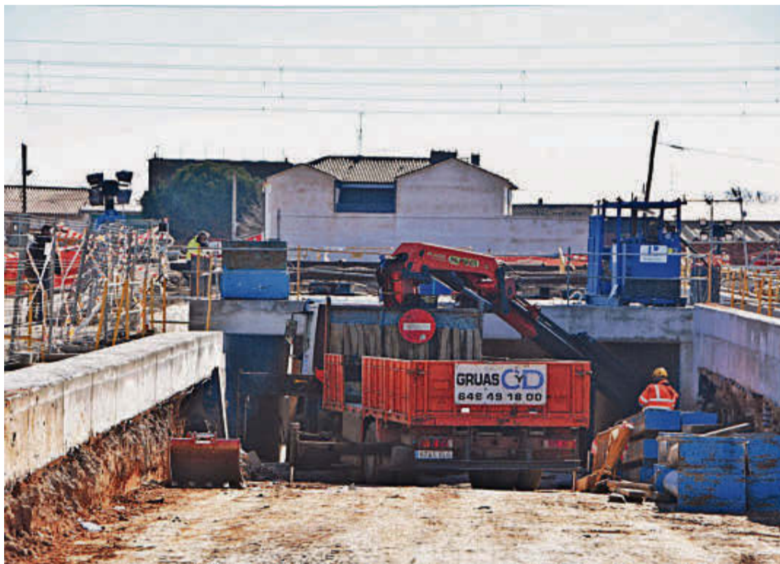
Los trabajos de ayer en la excavación del foso para habilitar el paso inferior bajo las vías en Gomecello. | EÑE
