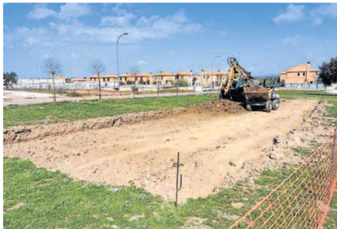
Trabajos de mantenimiento y reparación en Carrascal de Barregas. WORD
