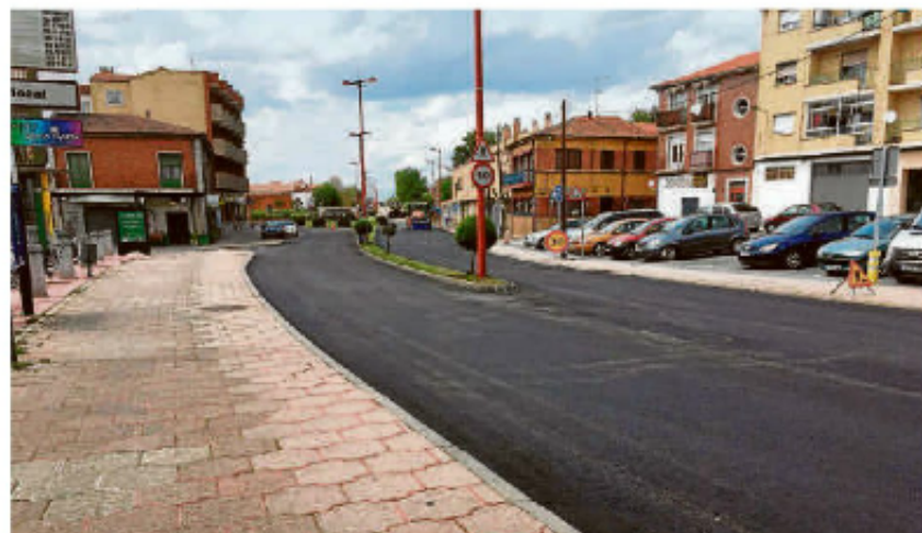
La avenida de Madrid ha sido la primera vía en la que han comenzado los trabajos de renovación del asfalto. | ENE
