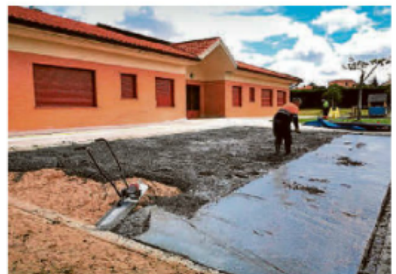
Las obras que se están ejecutando en el recinto de la guardería. | ÉNF
