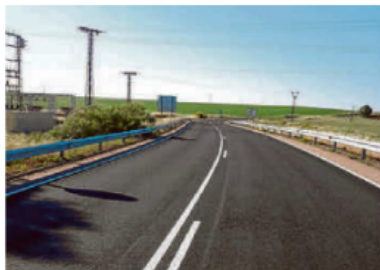
Firme completamente renovado en la SA-211.
