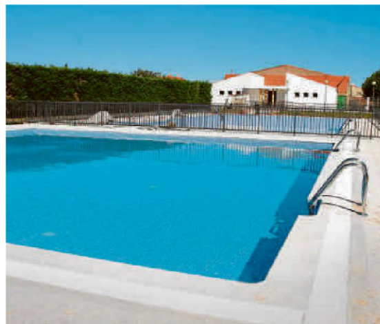
La zona de los vasos ha sido totalmente renovada. | EÑE
